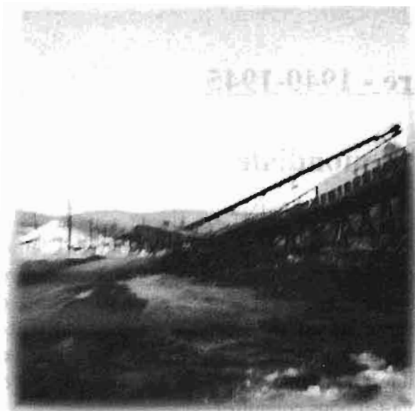
Le convoyeur Figure 8 - Au fond on peut voir la pile de «chips»
