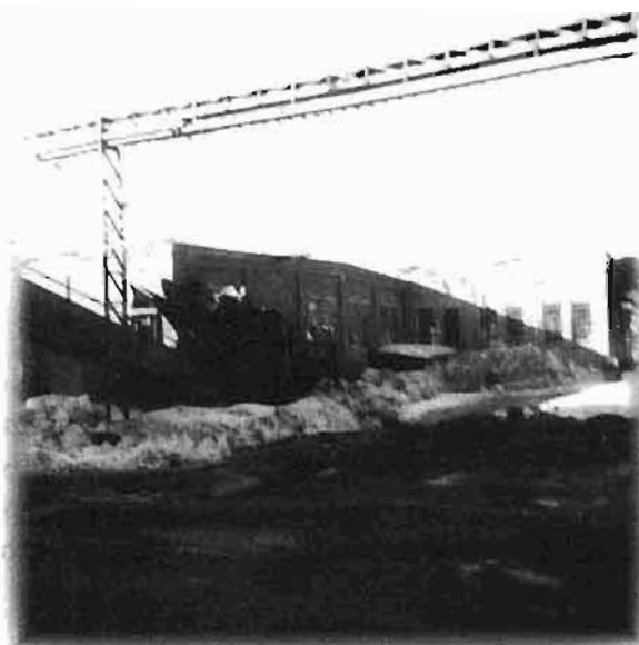
Façade du côté Sud - Côté du «groundwood» - 1970
