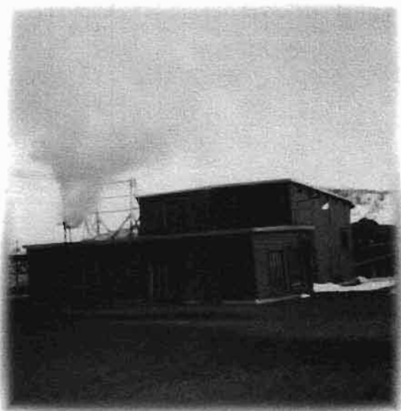
Sur cette photo, on peut voir l'«office» du surintendant et des contremaîtres et le «drive» du câble de la «wood room»
