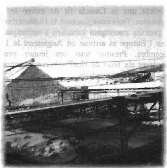
«Stacker» et pile No 1 - Photo de 1970
